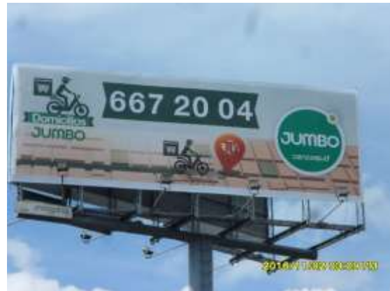
VISTA DEL TABLERO DE LA VALLA SENTIDO ESTE - OESTE
